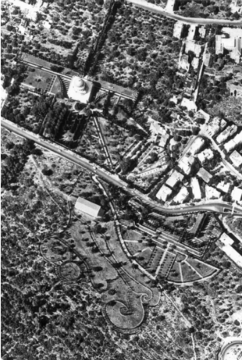
FRAMKVÆMDIR SHOGHI EFFENDI Á KARMEL FJALLI Grafhýsi Bábsins innan um garða og stalla sést hér efst til vinstri. Hér má sjá Minjasafnið og bogann að framanverðu auk hins merkilega sveigðaflúrs garðanna þar fyrir ofan.
